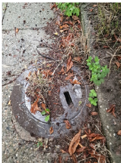
Obrázek 14: Pohled na uliční vpust před vchodem č.p. 825
