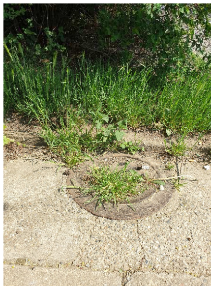
Obrázek 11 – Pohled na uliční vpust na pozemku par. č. 3289/10, která je pravděpodobně napojena do kanalizační přípojky.
