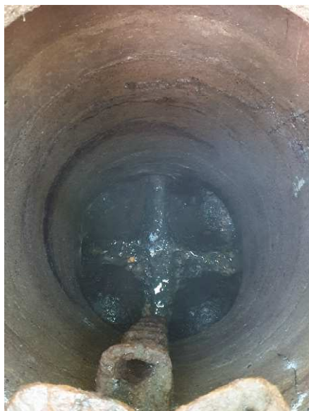
Obrázek 10 – Revizní šachta na pozemku par. č. 3289/10 před objektem č.p. 857 a 825
