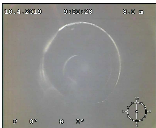
Obrázek 6: Snímek po 8m prohlídky po proplachu přípojky. Voda odtéká bez žádného nadržení vody v kanalizaci (3)
