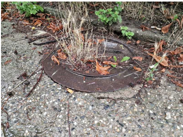
Obrázek 13: Pohled na uliční vpust před vchodem č.p. 825
