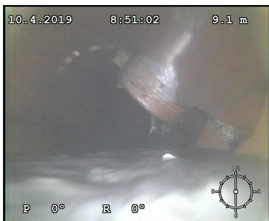
Obrázek 8: Snímek napojení kanalizačního potrubí (II)
