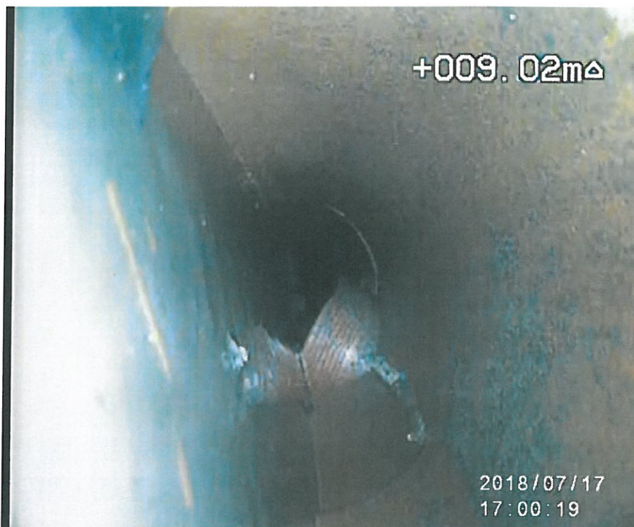
Obr. 2: Dobře viditelné zaústění potrubí od uliční vpusti do přípojky [6]
