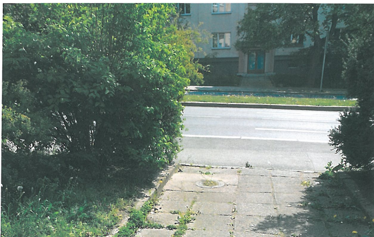
Obr. 1: Uliční vpust' před objektem č.p. 857 (pohled směrem od objektu č.p. 857 na komunikaci v ul. Na Padesátém)
